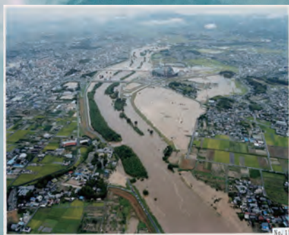
東海豪雨に伴う矢作川(愛知県豊田市)の洪水と左岸からの越水氾濫(出典：国土交通省豊橋河川事務所(2003)「矢作川流域の現状と課題・治水編」第2回矢作川流域委員会資料)
