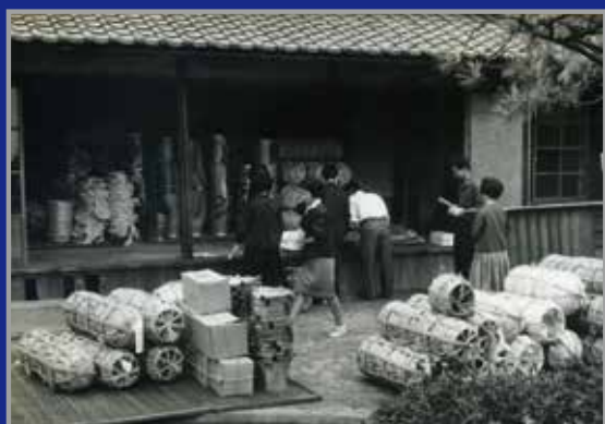
仮締切工事に携わった市民による作業の様子 (高浜市提供)
