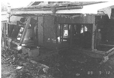
流木の衝突の衝撃力により破壊された家屋 「渓流における流木の発生、流下と災害」より
