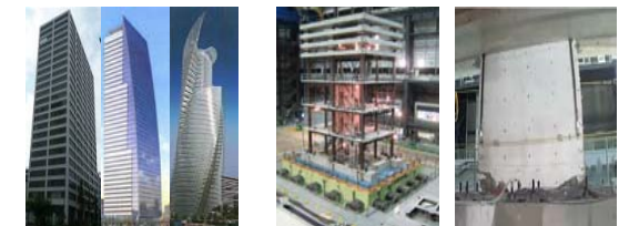
実在高層建物のモニタリング Eディフェンス実験で実大試験体の損傷モニタリング
