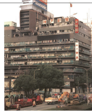
全壊したJR三ノ宮駅前の神戸新聞会館。窓ガラスは割れ、二次被害の恐れがあると、立ち入りは禁止され、撤収を迫られた(1月17日＝神戸新聞社提供)
