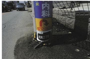
電柱の沈下（噴砂）
