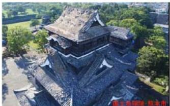
写真-11 地震による瓦の崩落(大天守側から)。【国土地理院】熊本城天守閣の被災状況 (2016年5月12日撮影)。
