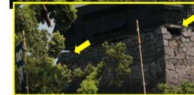
写真-14 石垣の沈下(左矢印)と部分崩壊(右矢印)(加藤神社から2016年8月11日撮影)。
