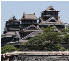
写真-10 大天守、宇土櫓、小天守のクローズアップ。現存の宇土櫓(中央)のみ瓦の崩落が生じていない(二の丸から2016年8月11日撮影)。
