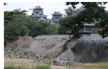
写真-19 成玄櫓台石垣の隅石部を残し中央部分の崩壊（2016年7月20日撮影）。
