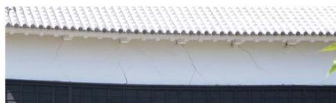
写真-36 基礎の崩壊により白壁部分にクラックが進展した馬具櫓. (2016年7月20日撮影)
