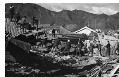
出典:みえ防災・減災アーカイブ「昭和19年 東南海地震による被災写真(尾鷲市)」より
