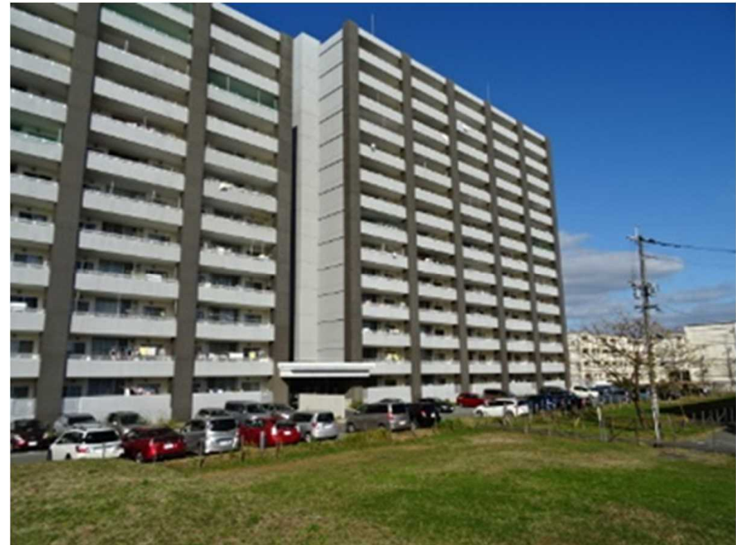
図4：被災者が入居している合同宿舎（熊本県：東町北住宅）
