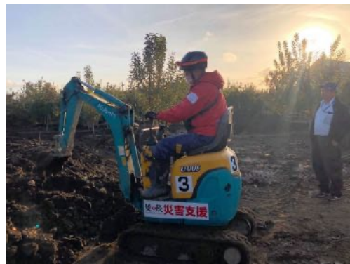
重機で土砂を撤去
