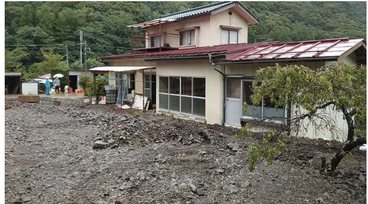
長野県辰野地土砂災害現場
