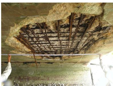
内部の鉄筋が露出した橋梁
