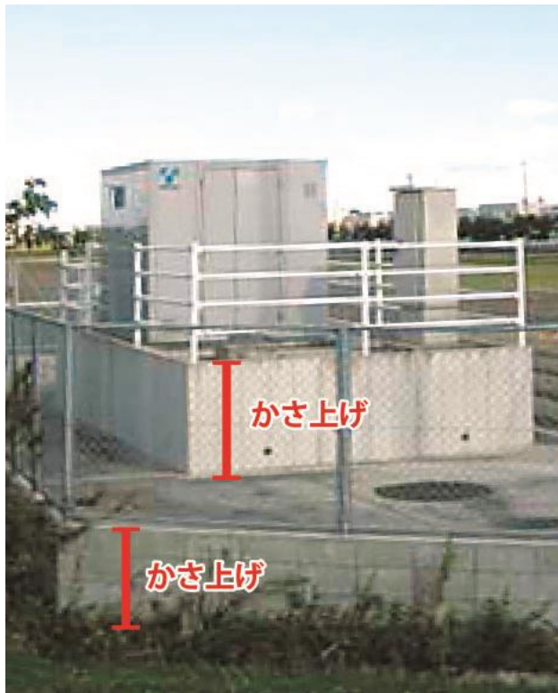
設備の嵩上げ
