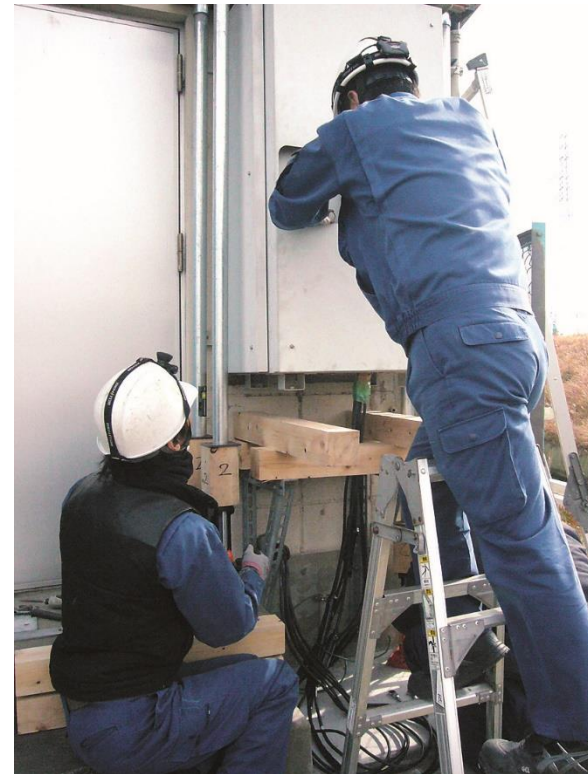
電気・通信設備の嵩上げ
