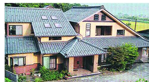
全面的なリフォームに伴い、耐震補強した 松山勝彦さん宅の外観＝福井県勝山市で
