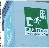
松原住宅の屋上付近に表示された津波避難ビルマーク。宮城県南三陸町志津川で
