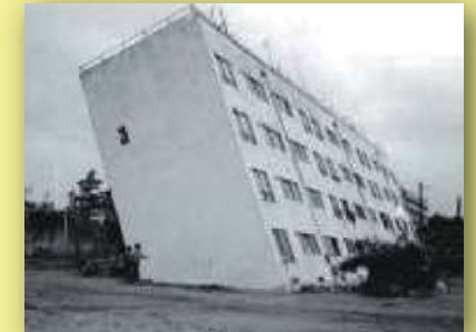
建物傾倒 (新潟地震)
