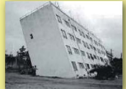
建物傾倒（新潟地震）
