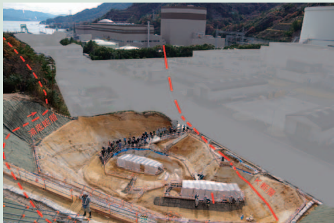
敦賀原発敷地内の断層調査（原子力規制庁の資料より）
