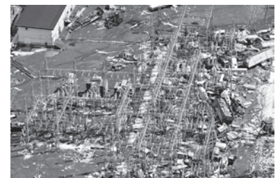
津波による変電所の被害：東北電力株提供
