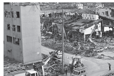
懸命に電柱を建てる：東北電力株提供
