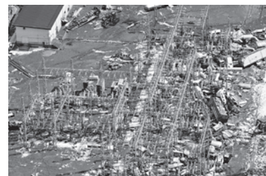
津波による変電所の被害：東北電力株提供
