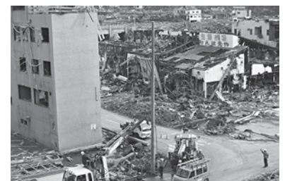
懸命に電柱を建てる：東北電力株提供
