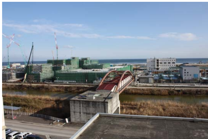
仙台市南蒲生浄化センター復興工事
