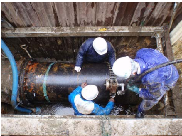
国見第二配水幹線復旧工事
