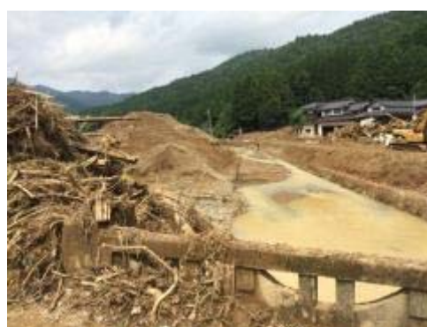
図 7 鴨阪橋より上流を望む
