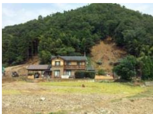
図 7 住宅背面斜面の崩壊状況
