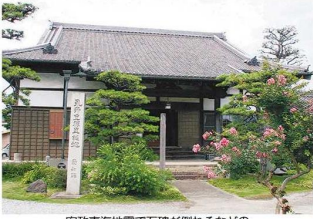
安政東海地震で石碑が倒れるなどの記録が残る宝珠寺。碧南市音羽町で。
