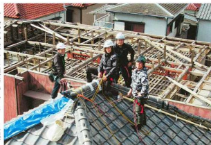
台風15号で被災した屋根のフルシート張り作業に当たる伊藤純さん（右から二回目）と、四番隊のメンバー（千葉県袖ヶ浦市）
