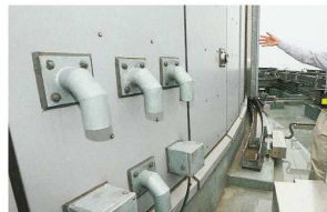
地上458mに設置された雲粒観測装置を説明する防災科学技術研究所の三隅良平さん(左)=東京都墨田区の東京スカイツリー。右は組み立て説明する永井和広さん。煙突のような部分から光を放射する=川崎市川崎区で
