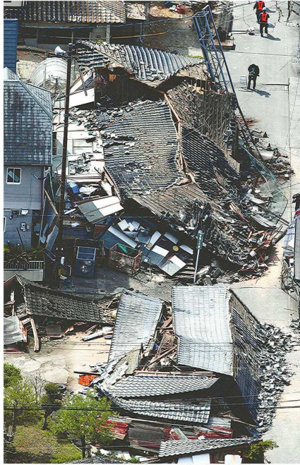
地震で倒壊した家屋―熊本県益城町で、本社へ「まなづる」から
