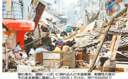
崩れ落ち、道路いっばいに倒れ込んだ木造家屋。耐震性の差がそのまま被害に直結した。1995年1月18日、神戸市長田区で
