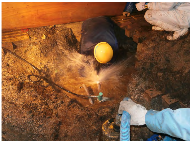
写真4：熊本地震発生後における緊急止水作業の様子 (名古屋市上下水道局提供)
