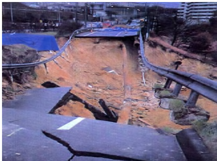
写真5：阪神・淡路大震災で宙ぶりになった都市ガス導管 (ガス地震対策検討会報告書(1996年1月)より)
