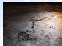
妙喜寺に残る地割れ跡
