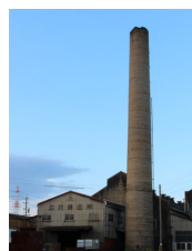
②折損した煙突 平成27年撮影
