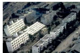
1964年新潟地震液状化被害のアパート写真, 国産工学会, 丸善出版
