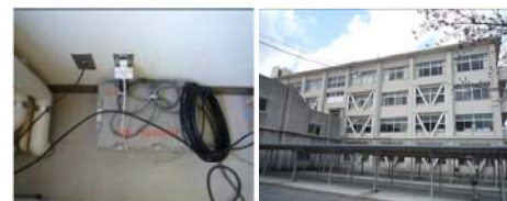
図6 高校校舎の強震計設置状況例
