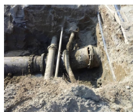
鹿行広域水道用水供給事業の取水棟への取り付け部の可とう管、周辺小口径管路が地盤と共に沈下したため、継手部で漏水
