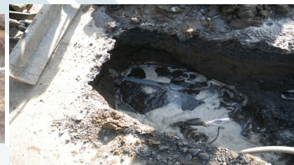
千葉市 漏水被害
