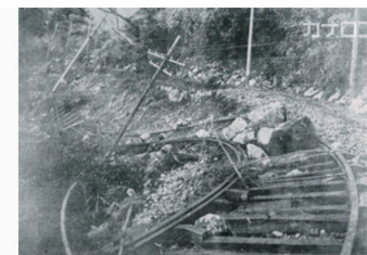
関東大震災で崩壊した登山鉄道の線路（箱根町提供）
