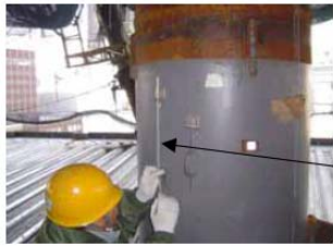
インナー C204 センサー 取付中 センサー
