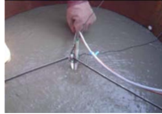
充填コンクリートに埋込
