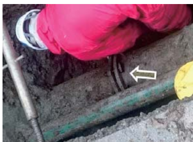
機械的接合の継手緩み漏れ
