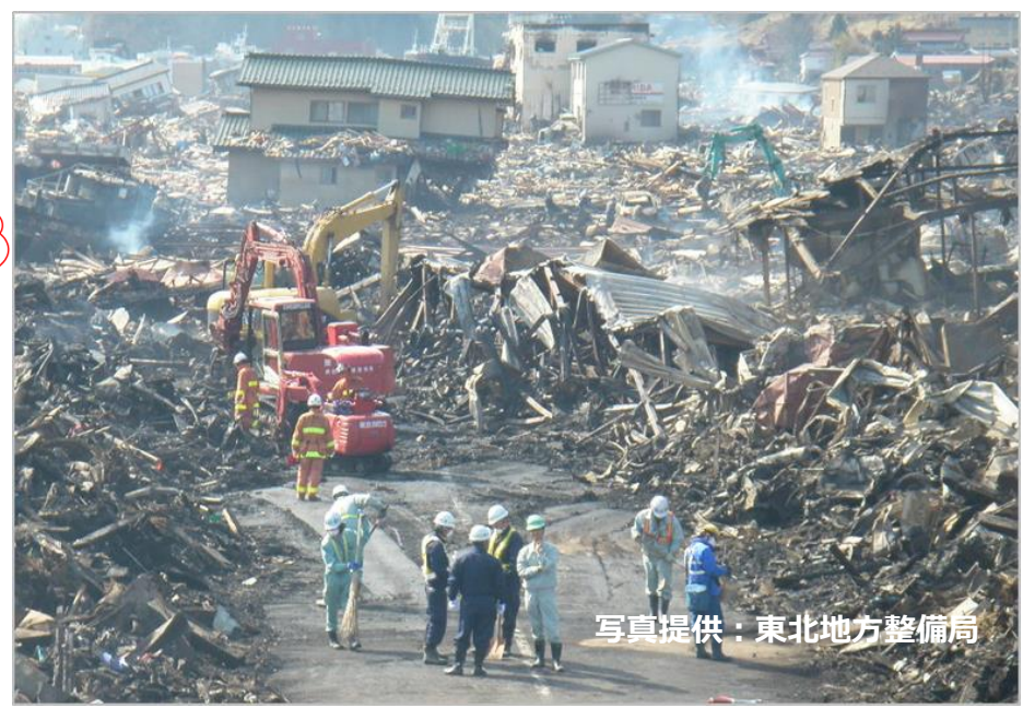
東日本大震災での道路啓開
